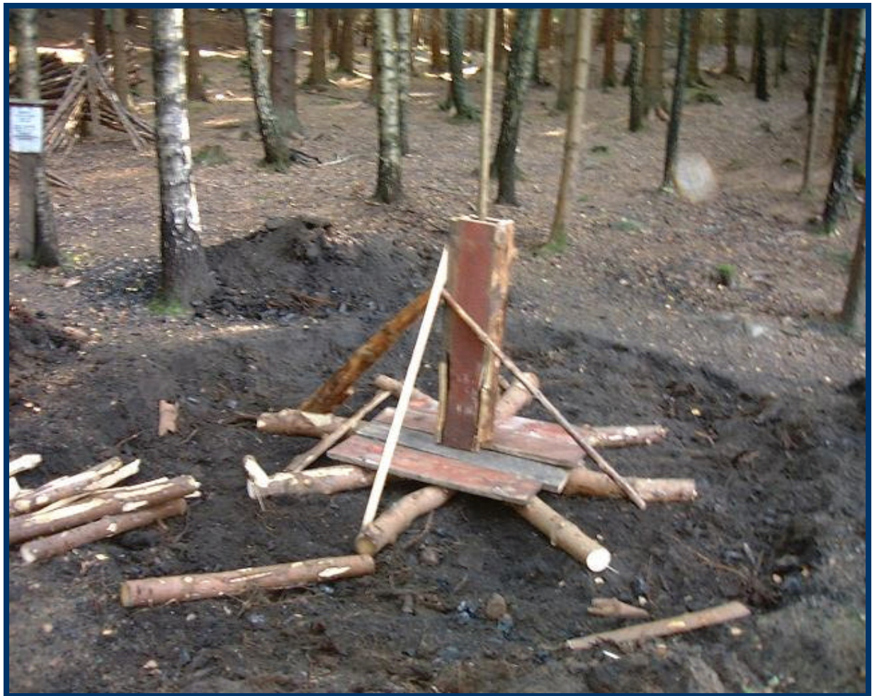
Milbotten är rensad, ”ekrarna” är utlagda, kungen är rest och riktstaken rest. Även golvbygget är påbörjat.
